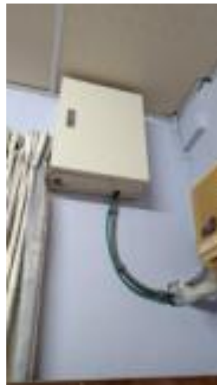
老舊電線更換增設電箱開關-宜蘭善牧學園內 220V 電源線路與開關已過於老舊，未免影響建物安全與工作人員服務品質，採取重行佈線、重設開關箱之改善方式，以避免安全風險
