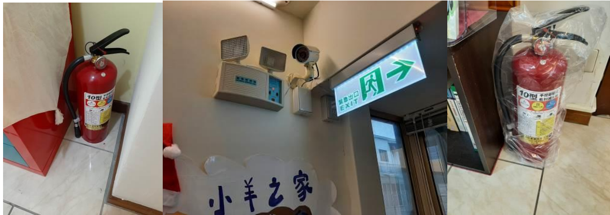
提供服務對象安全無虞之空間環境，增加消防安全設備與施工。
