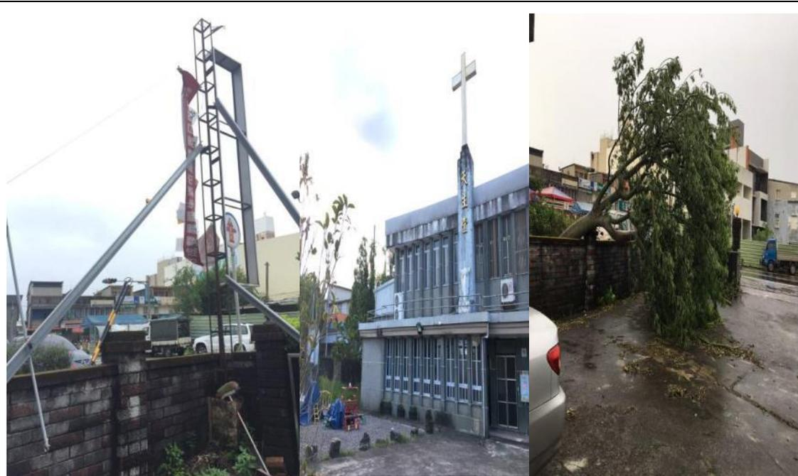
因颱風關係，樹木倒塌、穩固招牌的 c 型鋼斷裂，導致招牌搖搖欲墜
