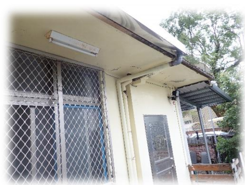
學園環境整建-屋舍排水工程
