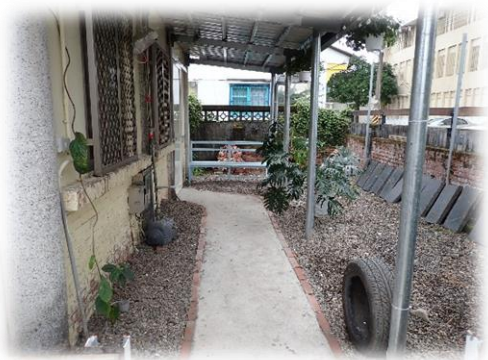
學園環境整建-搭建鐵皮屋
