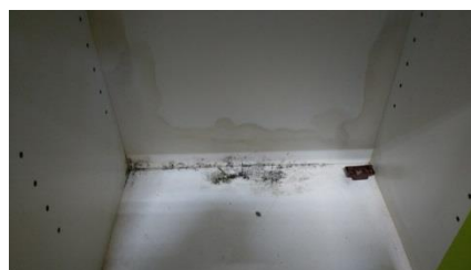
更換發霉、破裂、不堪使用之置物櫃
