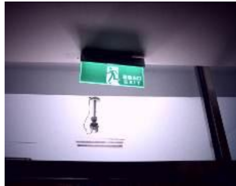
逃生出口指示燈的更新與維修
