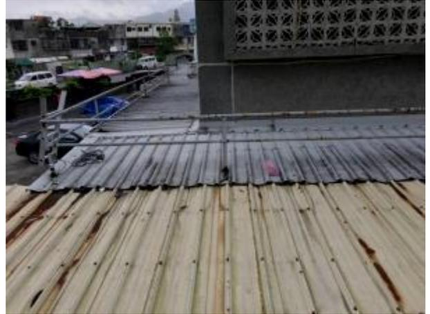
舊鐵皮用拼接的，縫隙生鏽漏水嚴重
